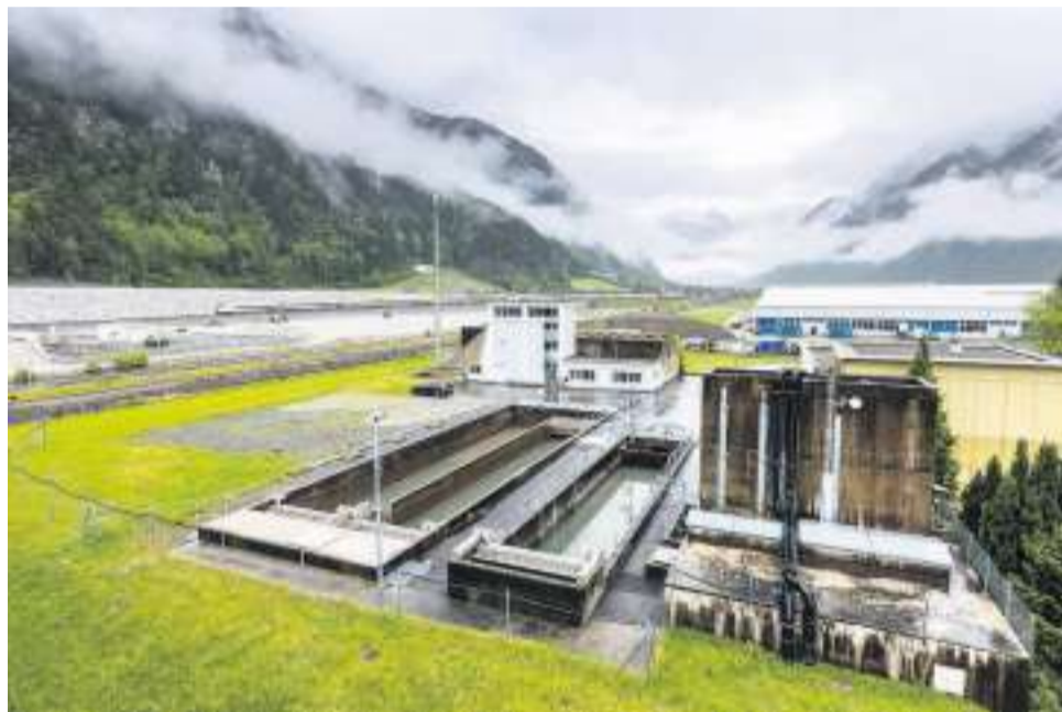
Idealer Labor-Standort: Die ausgediente ARA Erstfeld, neben dem Tunnelportal (links).
