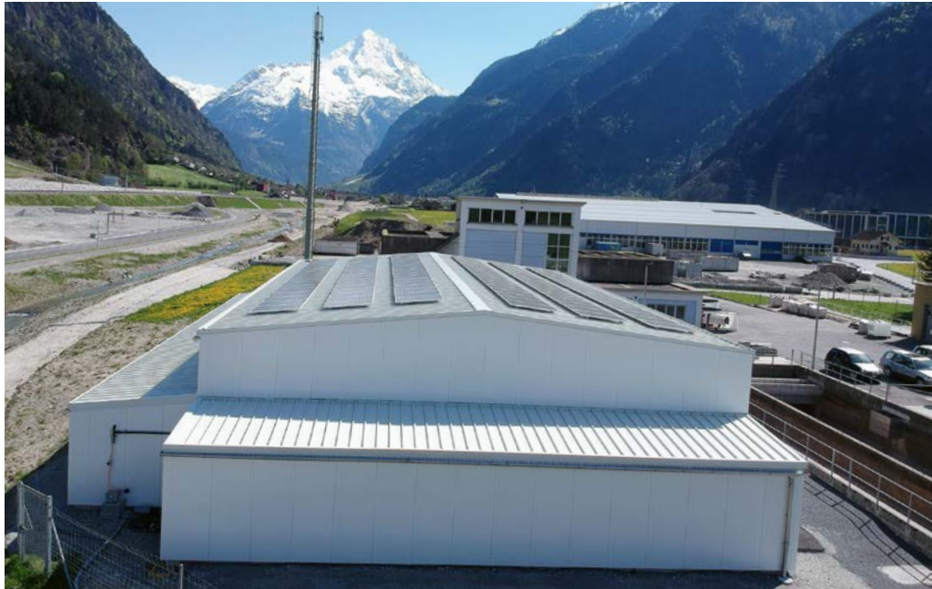
Seit 2018 gedeiht unter diesen Dächern Zanderfisch. Basis 57 realisiert im östlichen Teil der ehemaligen NEAT-Baustelle einen grösseren nachhaltigen Aquakultur-Betrieb. Bild: Basis57
